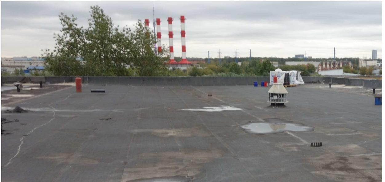
**Фото 14.** Общи вид вентиляционных выходов и ливневых воронок
